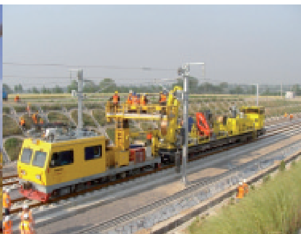
Macchine per la tesatura di linee elettriche ferroviarie
