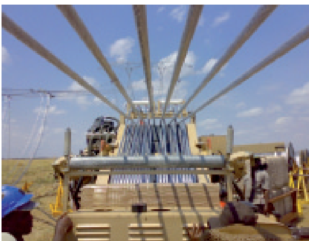
Macchine per la tesatura di linee elettriche e fibra ottica
